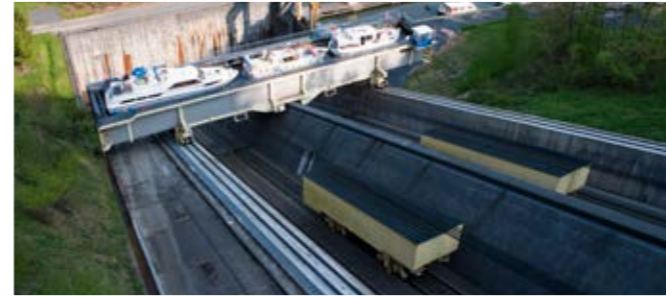
Das Schiffshebewerk in Arzviller.
