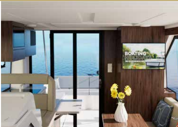
Thermostatisch gesteuerte Klimaanlage
